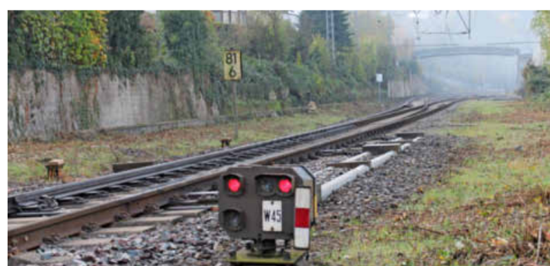
Nachrangig: Der eingleisige Abschnitt bei Möckmühl-Züttlingen gilt als Inbegriff der Frankenhahn-Misere, hat für Planer aber keine Priorität.
