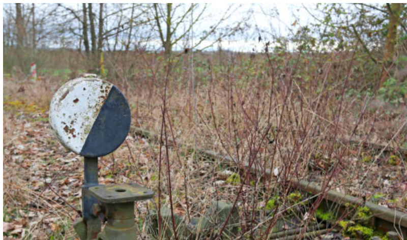
Zugewachsen, aber nicht überbaut: Die Bahnstrecke durch das Zabergäu kann für die Stadtbahn zu neuem Leben erweckt werden. Foto: Andreas Veigel
